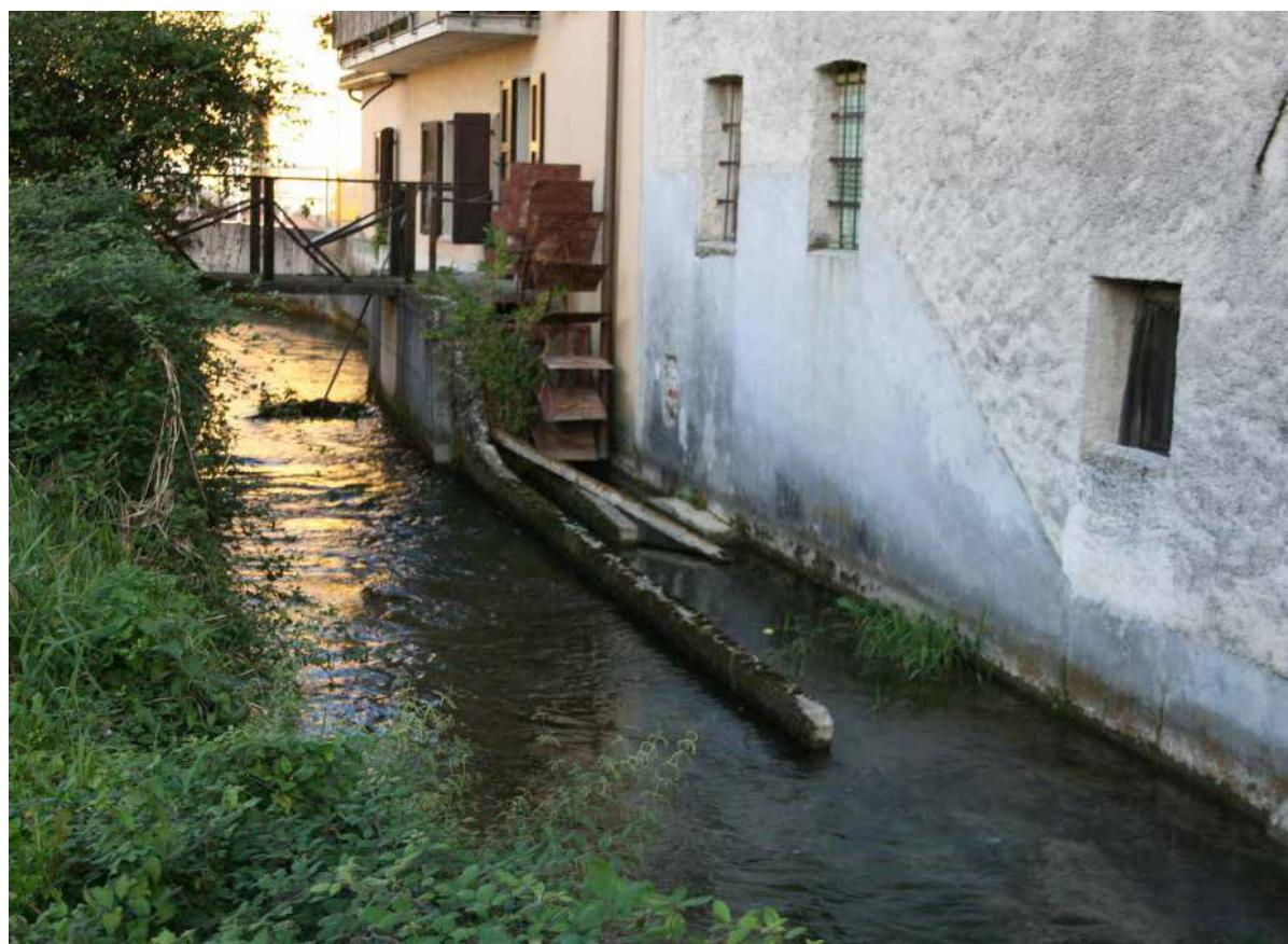
*Opere di derivazione e ruota idraulica di un opificio a Savorgnan del Torre - IMG\_8272*
